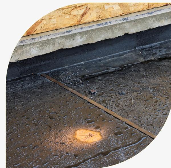
▲ Reprise de l'étanchéité et raccordement avec le revêtement existant
