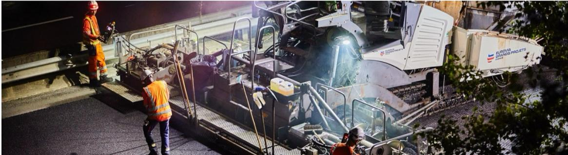
Dans le cadre de son programme d'entretien et de maintenance, VINCI Autoroutes réalise entre le 5 mars et mi-octobre 2024 la rénovation des chaussées de l'A63 entre Ondres et Biarritz. Lors de cette opération, 36 km de chaussées seront renouvelés sur la section courante, les chaussées des échangeurs de Bayonne-Sud, Bayonne-Nord et Ondres seront également rénovées à cette occasion.
